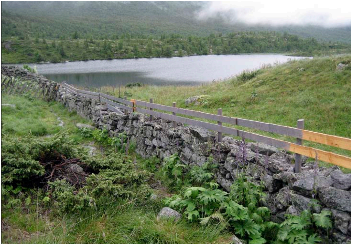
Eksempel på hvordan man har løst avstenging av beiter. Eieren har beiset treverket for at det skal gli inn i miljøet. Foto Kulturminnefondet.
