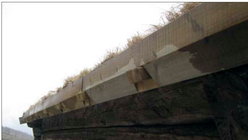
Bruk av trykkimpregnerte materialer på torvhovdsstokk og raftsperer. Foto Kulturminnefondet.
