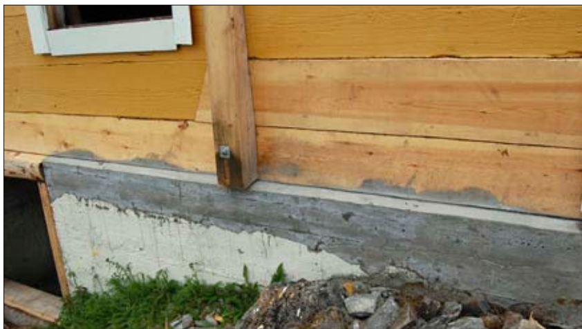
Etter utskifting av yttervegger. Bildet viser istandsetting hvor det er lagt vekt på å skifte ut kun skadde deler. Foto: Kulturminnefondet.
