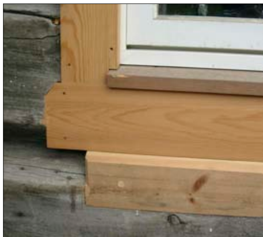
Eksempel på innfesting av vinduskarmer med skruer. Foto: Kulturminnefondet.
