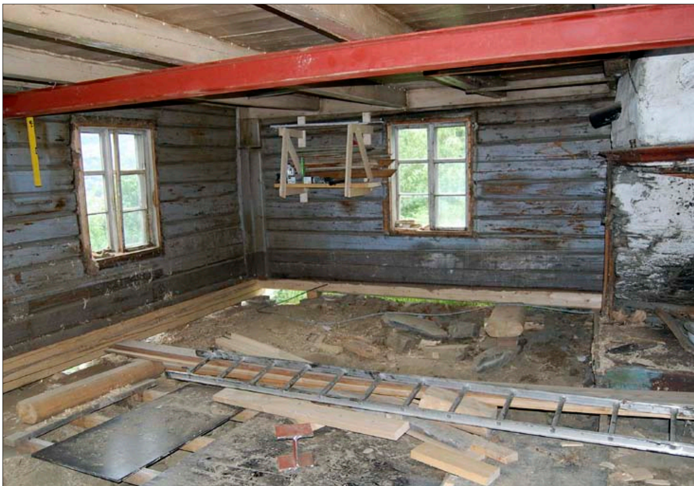
Bjelkelaget er understøttet av en H-bjelke som skal innpaneeles. Eksempel på valg av løsning som ikke er tråd med eldre tradisjoner. Foto: Kulturminnefondet.
