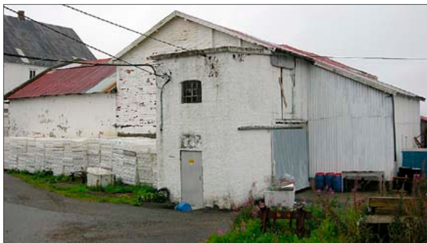
Samme objekt som over, men før utbedring. Foto fra søknad.
