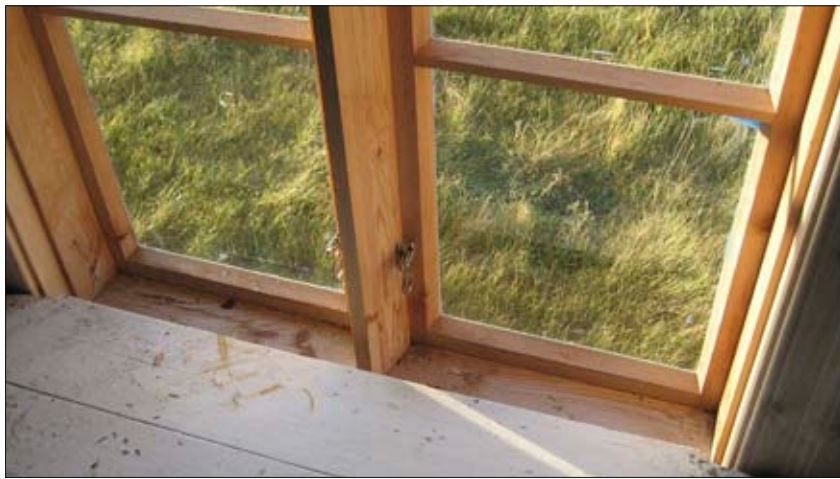
Bildene viser vinduer før og etter utskifting. Foto til venstre Kulturminnefondet, foto til høyre fra søknad.
