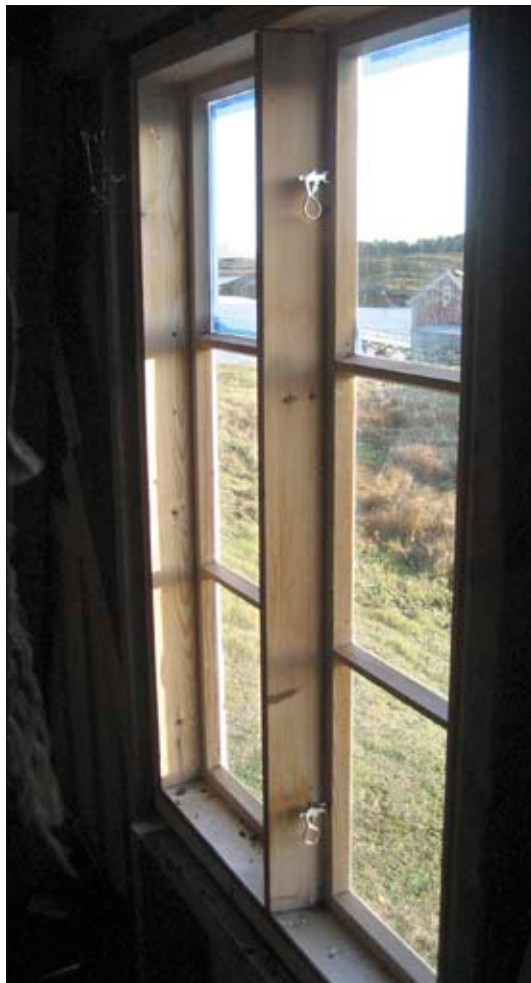
Bildene viser eksempler på at det brukes hasper av samme type som opprinnelig. Fotos Kulturminnefondet.
