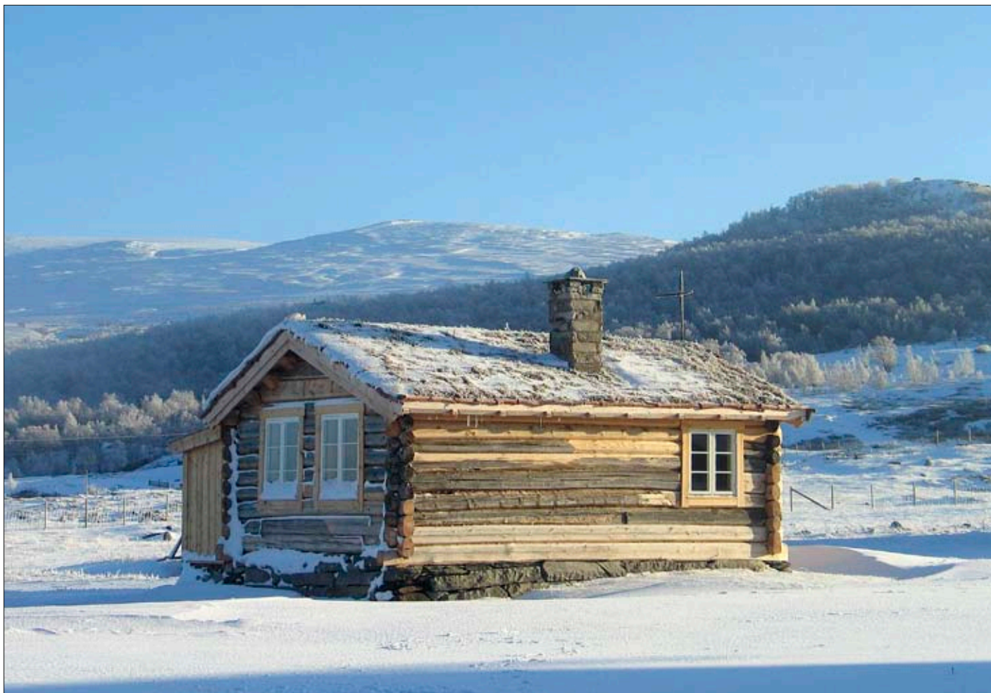
Stue etter istandsetting. Foto fra rapport.
