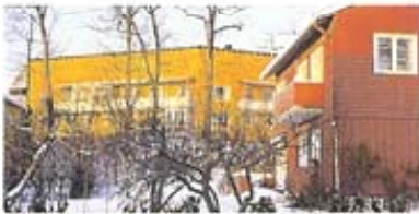
UJENS KONTRAST - Volum og form - Byggherrens med store volumer og åpne, smale byggherrens har store volumer og er i kontrast til den eldre husbyggverket. Materialer, detaljer og farger - I fargene, prikkete fasadeglass, hvite vinduer og den varierte fasadeformen skaper dialog med villene fra 1930-årene.
