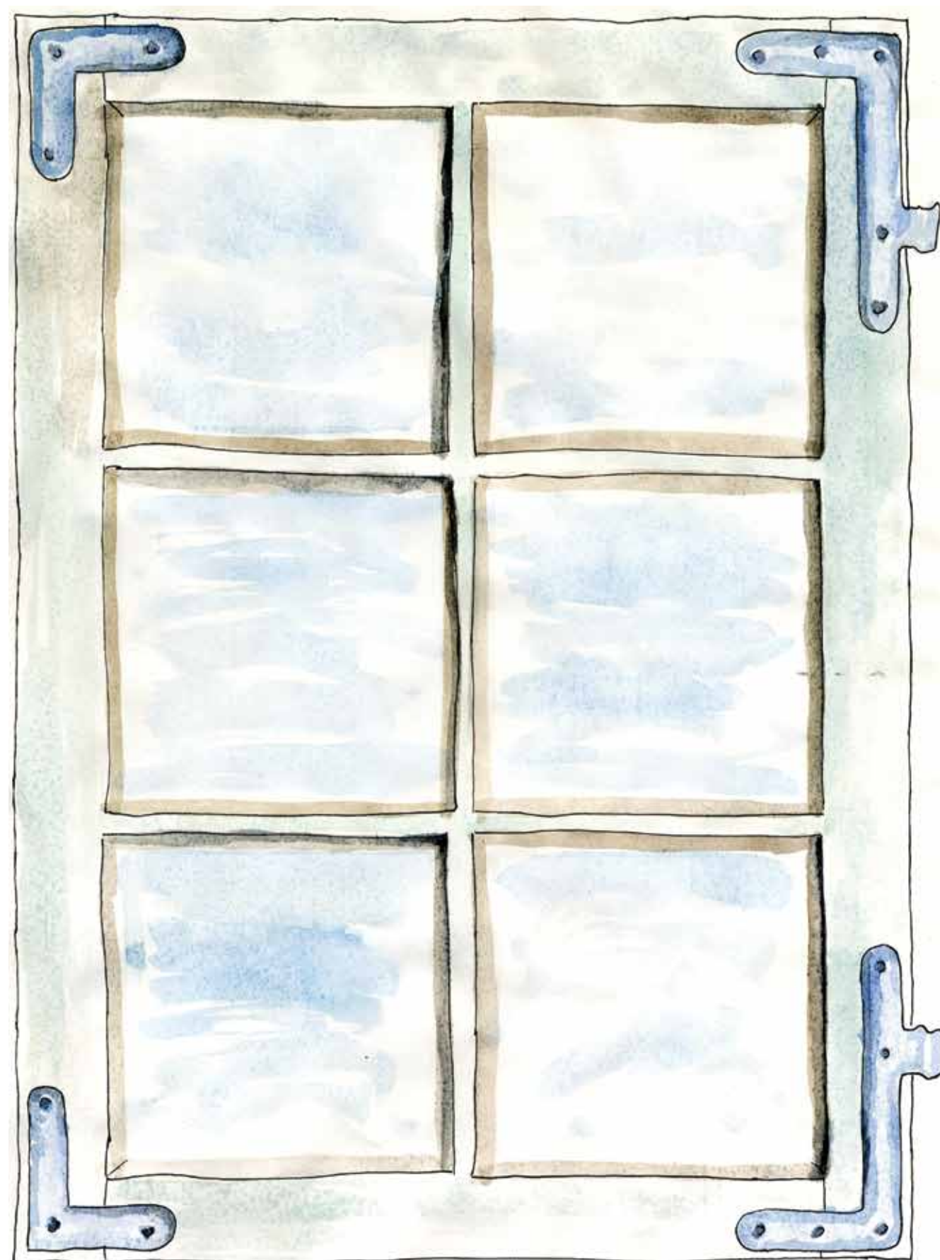
Vinduene på bryggen er av typen to-rams vindu med stabelhengsel og hjørnejern. Vinduene er antakelig fra tidlig 1800-tallet noe stabelhengslene med hjørnejern indikerer. Glasset i vinduene er blåst, dette kan vi se gjennom den bølgende tekturen i vindusrutene. N
