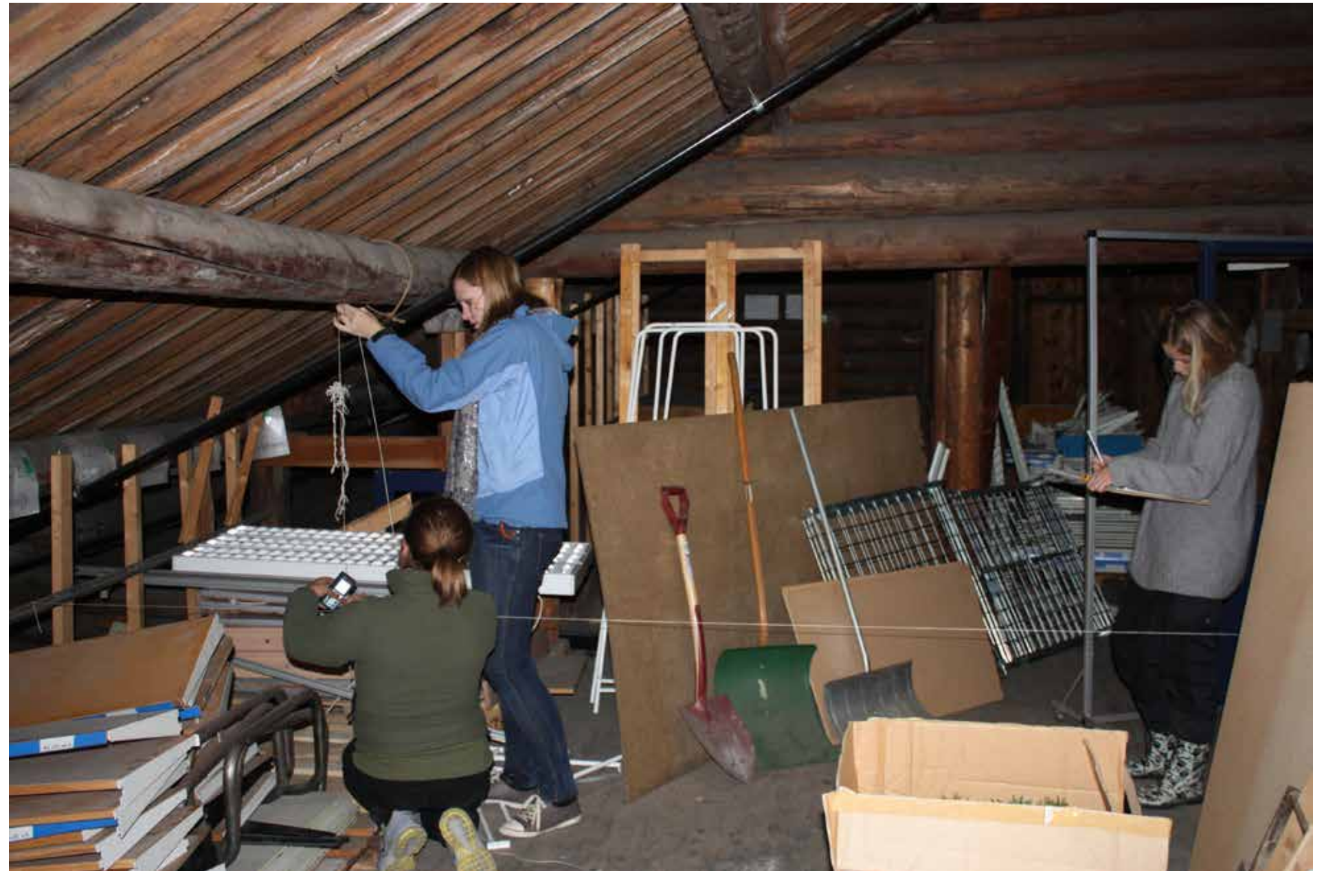
Oppmåling av tverrsnittet på loftet med referansetråd og laser. A
