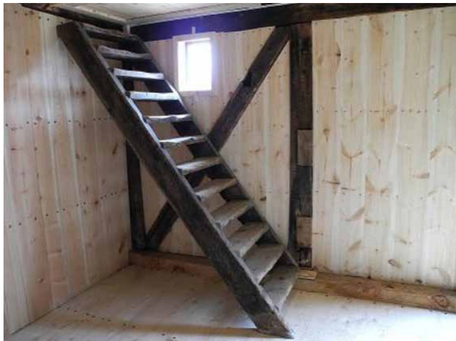
Gamle elementer og nylig restaurert panel, Røros. A
