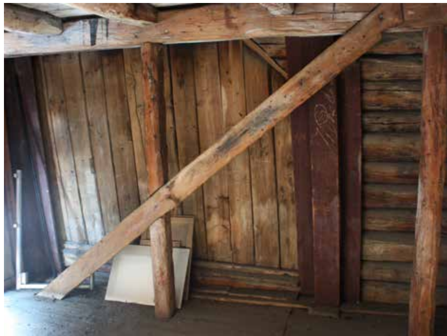
Porten mellom bryggene i 3. etg, som er stengt igjen med panel ^
