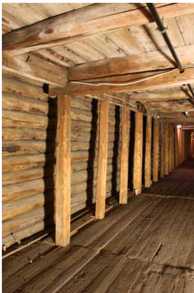
Konstruksjonen mellom de to bryggene. A
