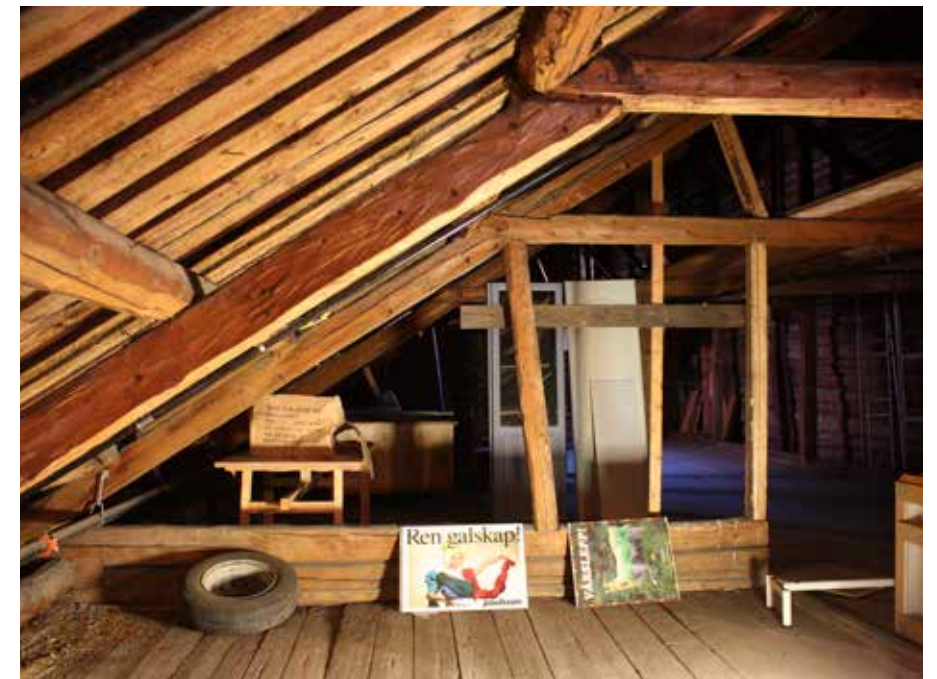
Det ensidige sperrebindet på loftet i brygge 55, som bærer halve taket og hemsen.. ^
