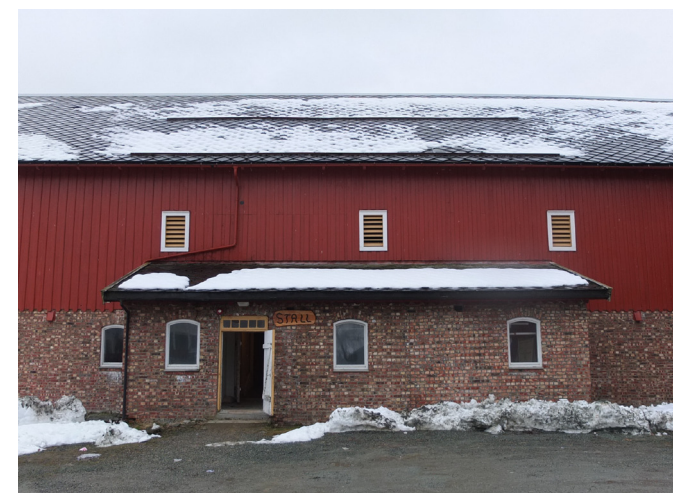
Stallingang i østfløyen
