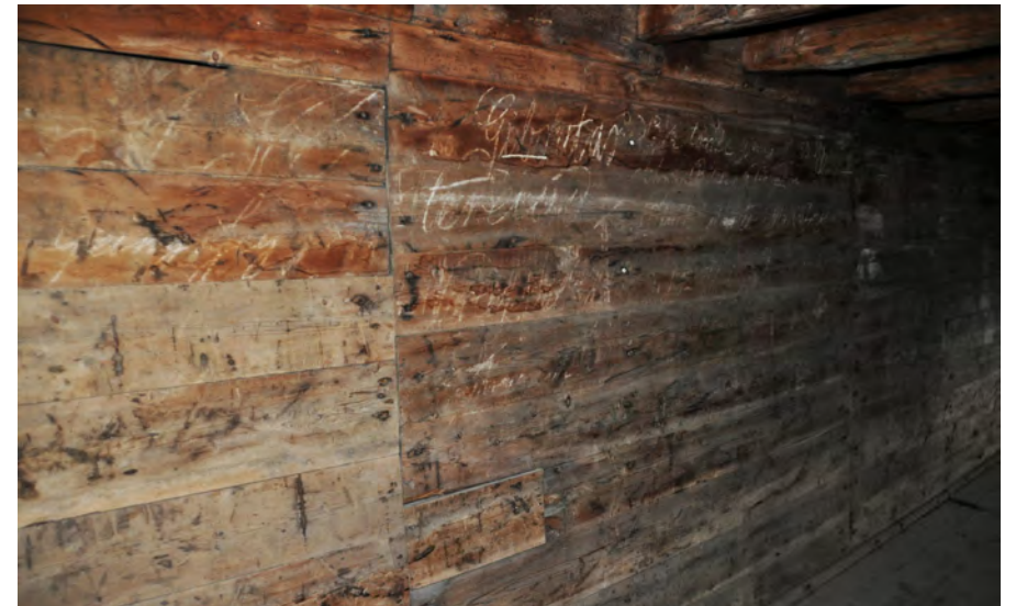
Kledning bindingsverkvegg
