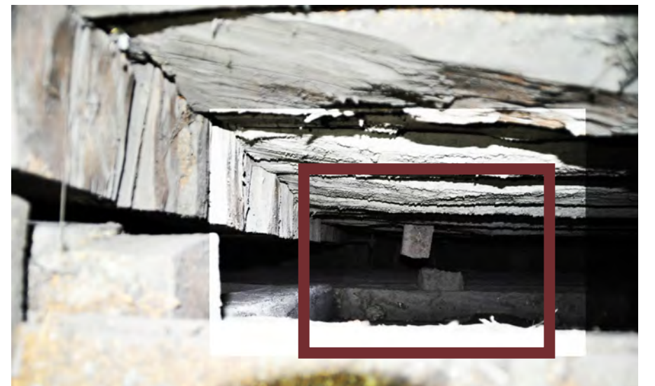
Bilde fra innside av vegg viser gulvbjelker som stikker ut gjennom veggen. dette er et tegn på at allerede fra bygginger er bryggene tenkt til å være under samme tak.
