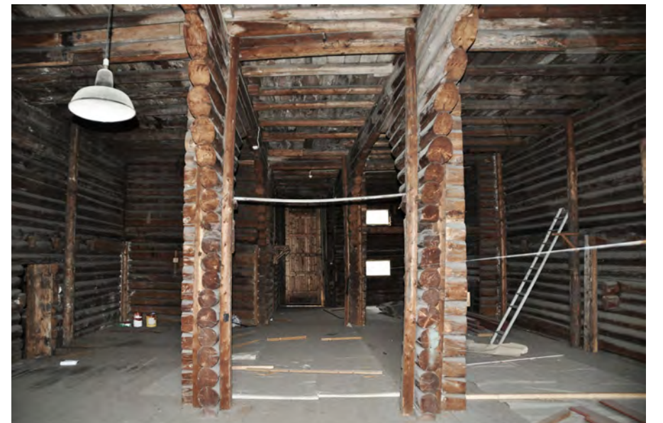
Rester etter vegger i midtfløyens 3. og 4. etg.
