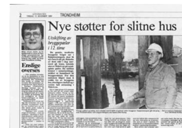
Utskifting av bryggepæler.
