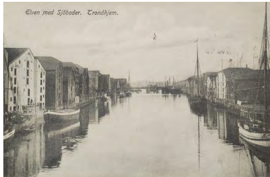
Fotografi fra 1907 som viser en senere variant av en utvendig konstruksjon mot elva. (kopi fra universitetsbiblioteket)
