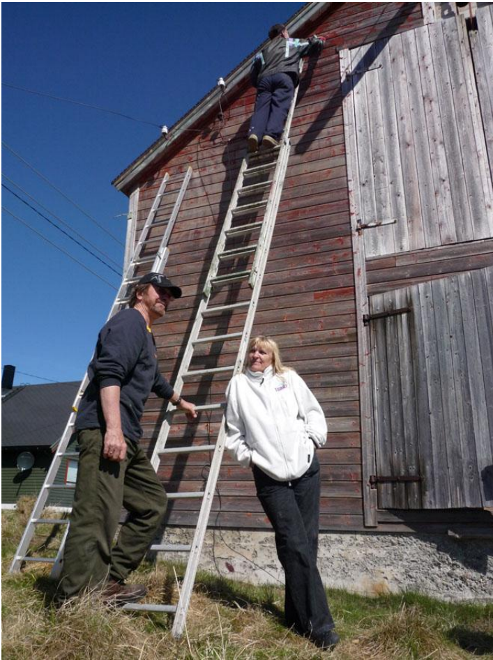
Dugnadsarbeidet i gang. Det ble litt skraping mens vi ventet på at malingen skulle bli ferdig
