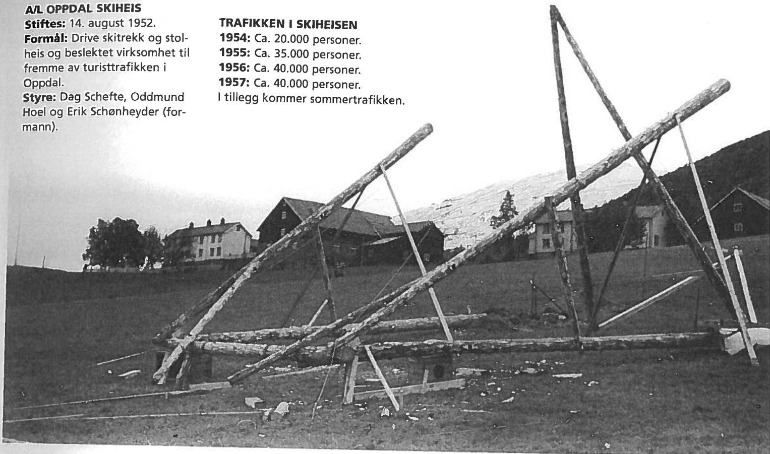
Hovdenheisen bygges høsten 1952. Den konstrueres av siv.ing. Arild Schlytter, som leverer det tekniske utstyret gjennom AIS Slepebaner. Iver Åsberg fra Oppdal er arbeidsformann når ingeniør Brinch setter opp heisen. FOTO: CORNELIUS JACOBSEN
